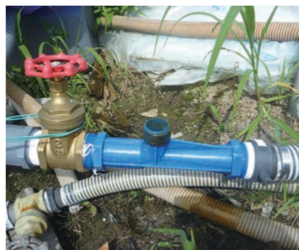
②設置状況
