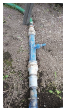
②ホースと灌水チューブの間に設置
