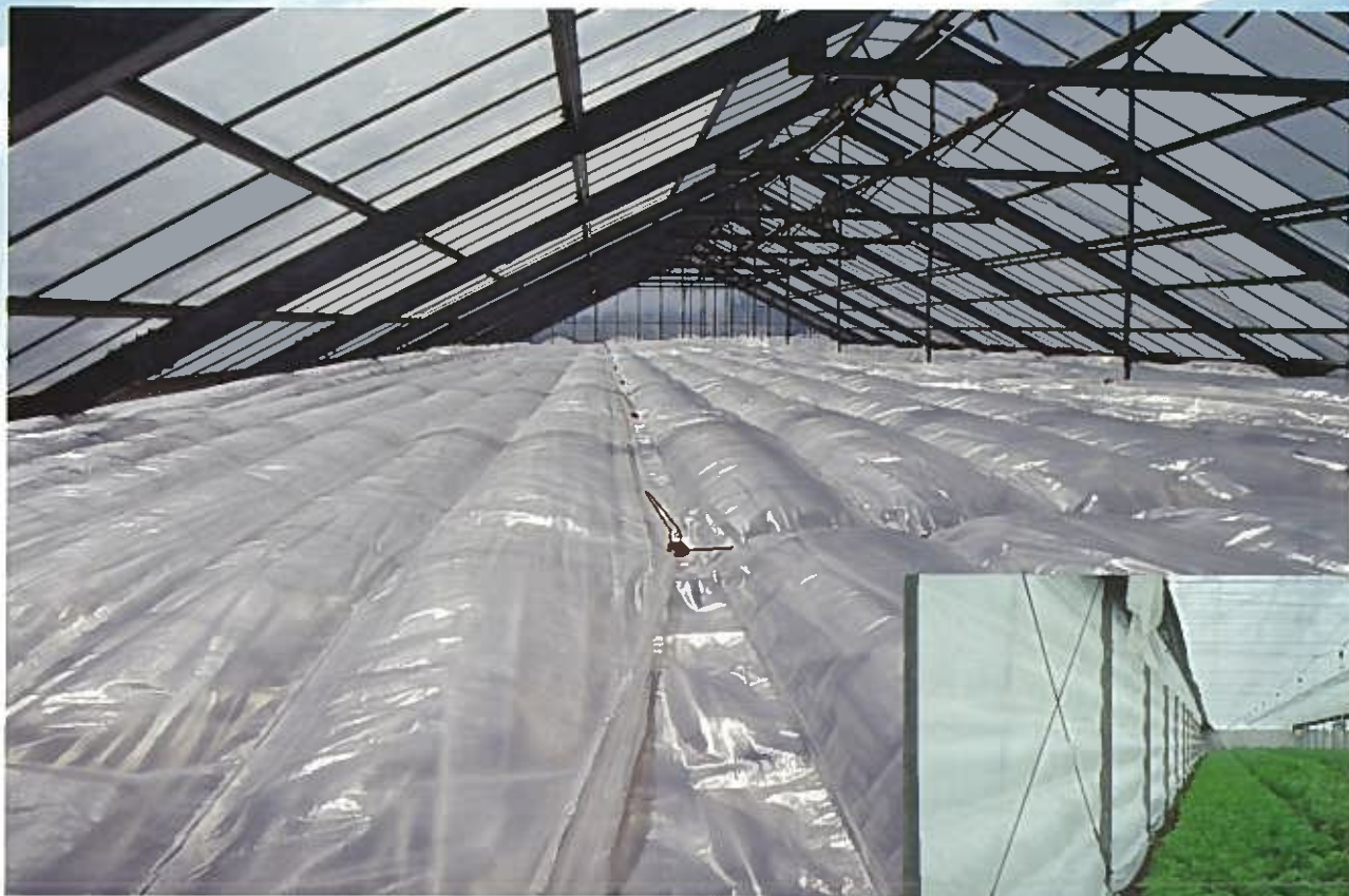
ハウス内張り屋根部の使用例
