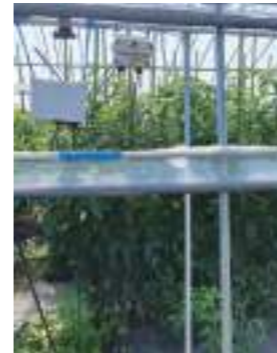
④みどりクラウド設置状況
