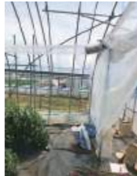
③ポリダクト設置状況
