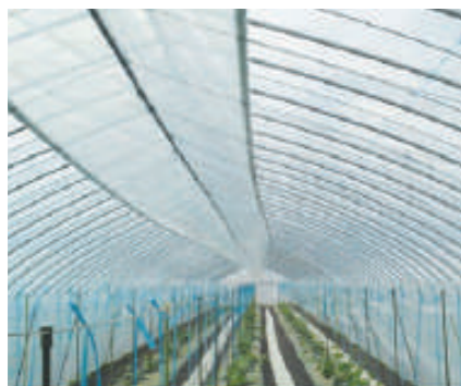
クリントートFX 展張状況
