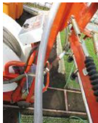
①ロッキイ設置状況(シャトル)
