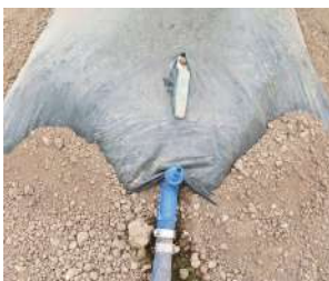
②試験品設置状況
