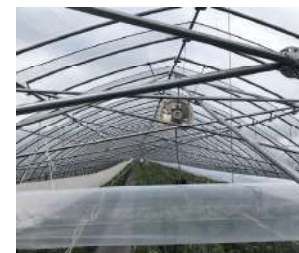
ポリダクト設置状況(7月5日～)
